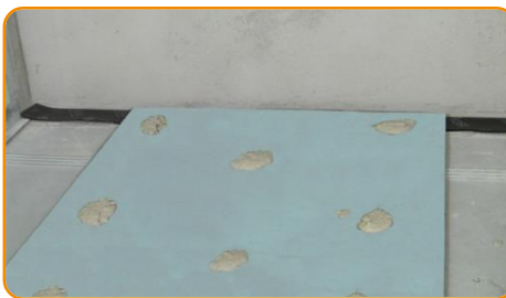
Aplicarea adezivului, în puncte, pe panou.
