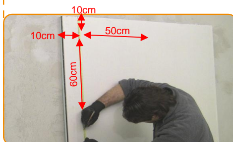
Pentru fiecare panou Rewall 33B marcați spoturi pentru 12 blocuri, 4 pe laterale și centru spre margine distanță de 10 cm în înălțime uniform distribuite
