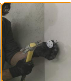
Executarea găurilor cu burghiu de 10mm și aplicarea fixărilor mecanice.
