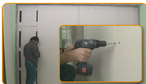
Fixarea, cu adeziv sau fixări, al celui de-al doilea strat de gips carton pe primul strat de gips carton, decalat.
