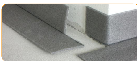
Izolarea colțurilor exterioare cu profil de colț, conform schiței.
