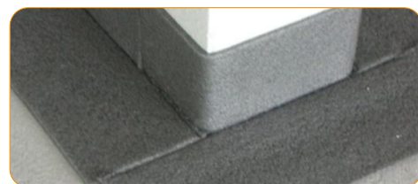
Aplicarea profilului de colț, perimetral, conform schiței.
