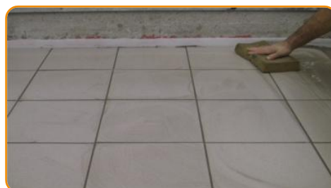
După întărirea chitului de rost, dalele de gresie se pot curăța.
