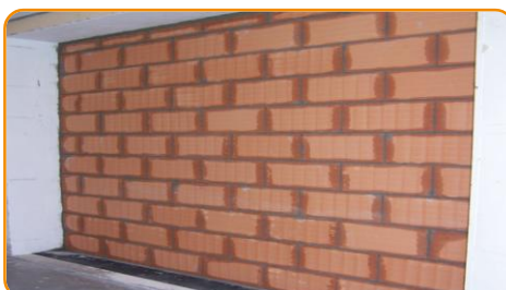
Ridicarea zidului, aplicând mortar rosturilor orizontale și verticale.
