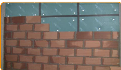
Ridicarea celui de al doilea zid, aplicând mortar rosturilor orizontale și verticale.
