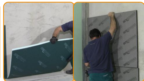
Aplicarea panoului prin presare omogenă.
