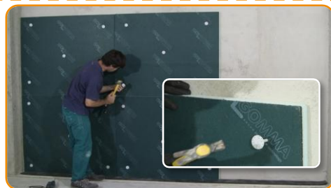
Aplicarea fixărilor mecanice din plastic prin batere cu ciocanul.
